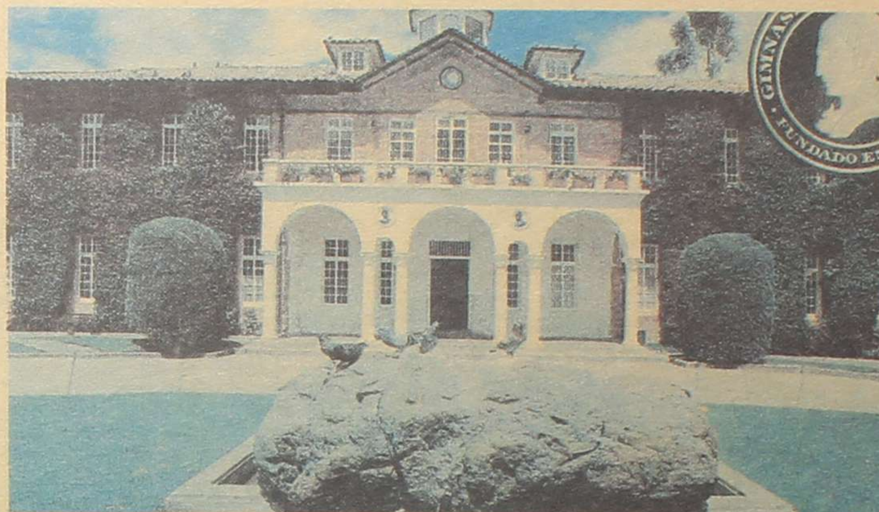
■ Fachada del Gimnasio Moderno, en Bogotá.
